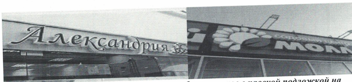
Рис. №4 Примеры вывесок из отдельных букв и знаков с плоской подложкой на декоративной панели
